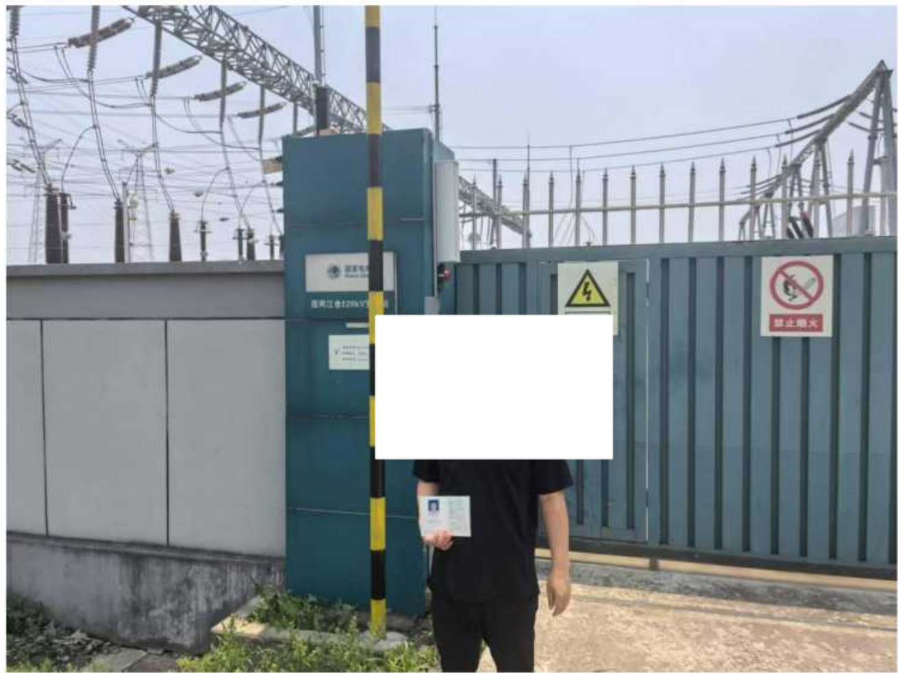
附件8：编制主持人现场踏勘照片
