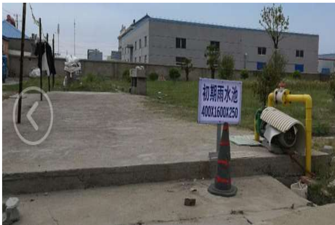
初期雨水收集池
