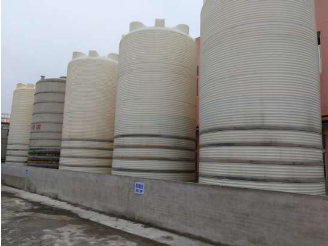
右侧两罐为车间含盐废水储罐、左一罐为三级洗水储罐、左侧 2/3 号罐为除盐后车间回用水储罐
