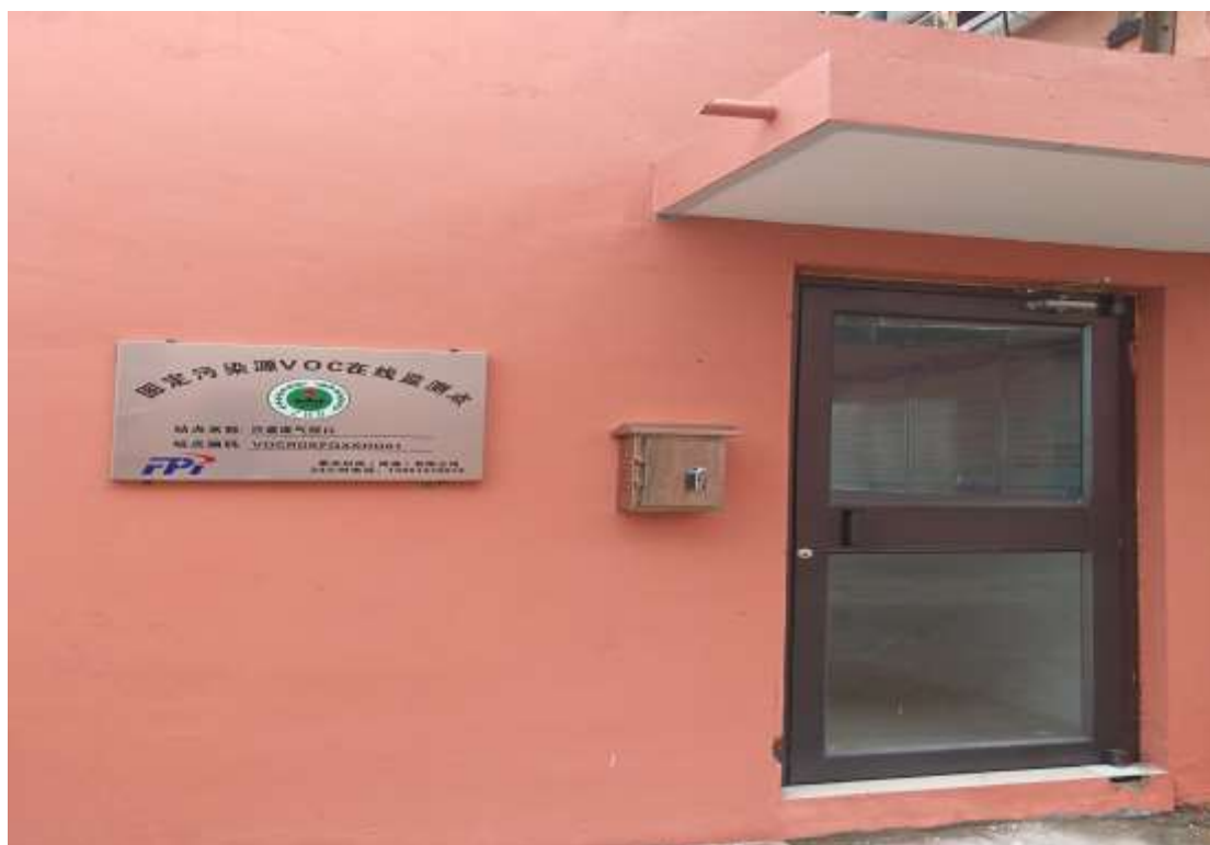
VOC 在线监测控制室
