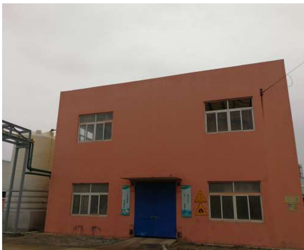
固废储存场所
